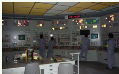
全交流電源喪失訓練
