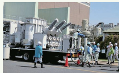
外部電源復旧訓練
