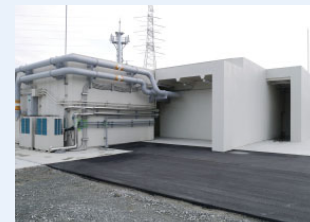
代替緊急時対策所
