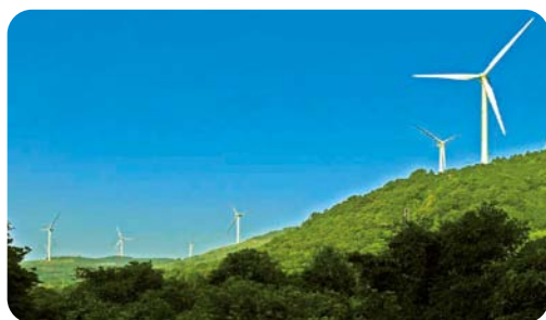
長島風力発電所(長島ウインドヒル株式会社)
