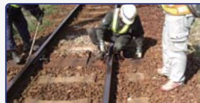
鉄道 レール継ぎ目板
