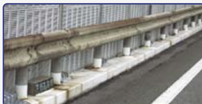
高速道路 遮音壁
