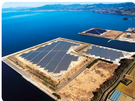
大村メガソーラー発電所
