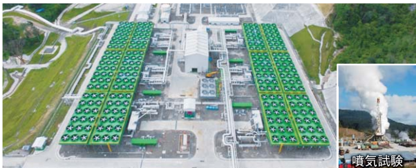
サルーラ地熱発電所初号機(インドネシア スマトラ島 サルーラ地区)
