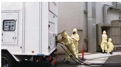
高圧発電機車の電源ケーブル接続
