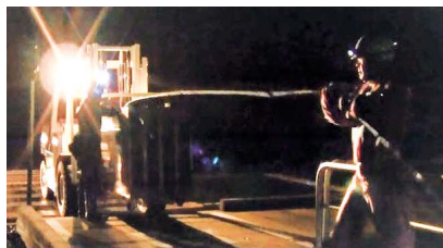
ホースの運搬・設置(夜間)
