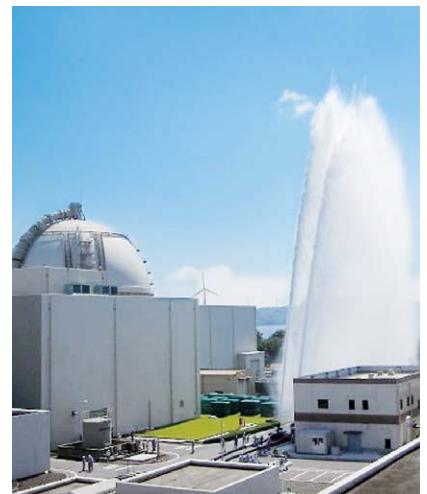
放水砲による放水
