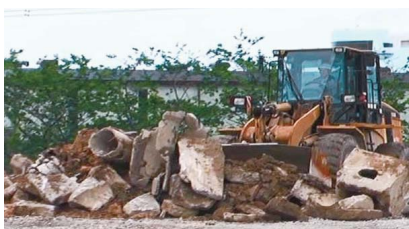
重機によるがれき撤去
