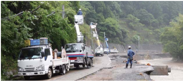
配電線路の新設
