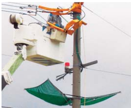
落下防止ネット
