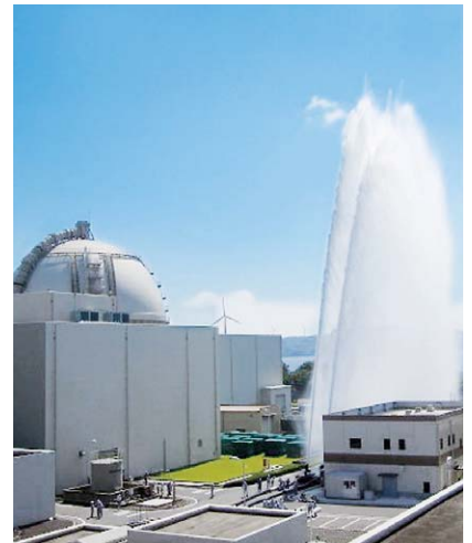
放水砲による放水
