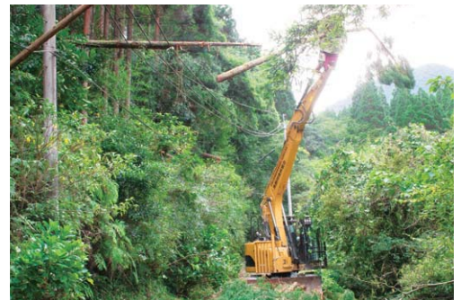
重機による倒木除去作業
