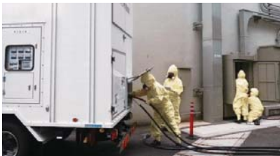
高圧発電機車の電源ケーブル接続
