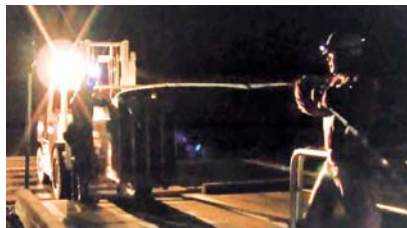
ホースの運搬・設置(夜間)
