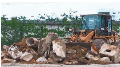
重機によるがれき撤去
