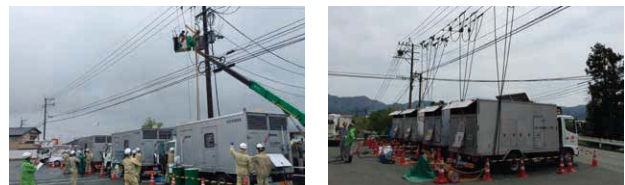
高圧発電機車による送電
