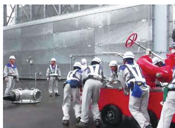
◇放水砲の設置
