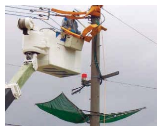
配電工事中の落下防止ネット使用
