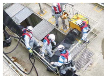
◇海水を取水する水中ポンプの設置
