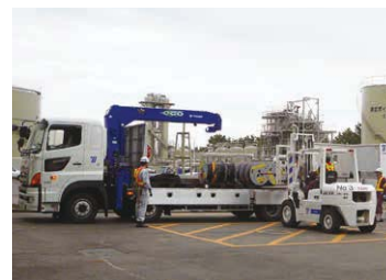
◇電源ケーブルの運搬
