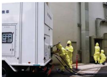
◇高圧発電機車の電源ケーブル接続
