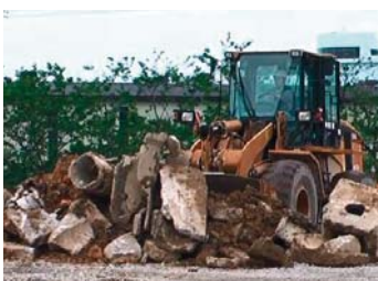
◇重機によるがれき撤去
