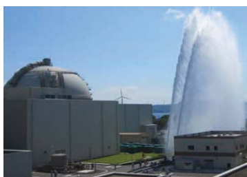
◇放水砲による放水
