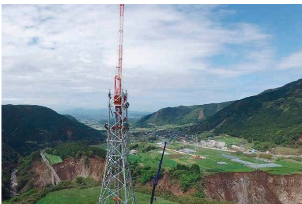
熊本地震復旧作業(仮送電線ルート建設工事)
