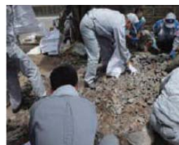
割れた瓦の撤去作業
