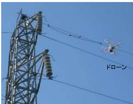
送電線の設備確認状況
