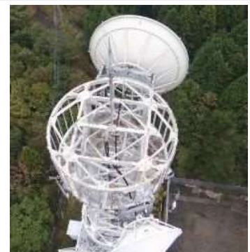
通信無線鉄塔の巡視状況
