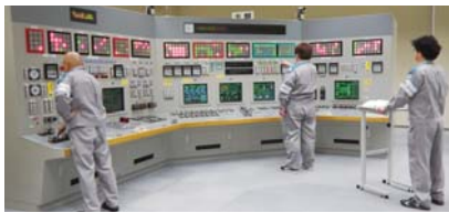
シミュレータを使用した運転操作
