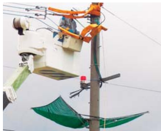
落下防止ネット
