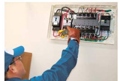
分電盤の点検
