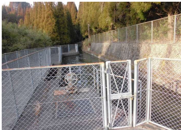
〔笹川発電所水路〕
