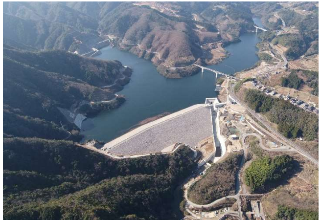
〔大分川ダム全景 国土交通省提供〕
