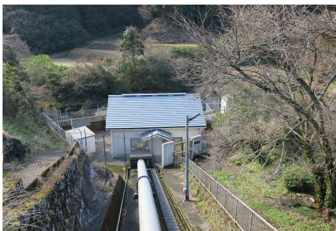
〔笹川発電所全景〕
