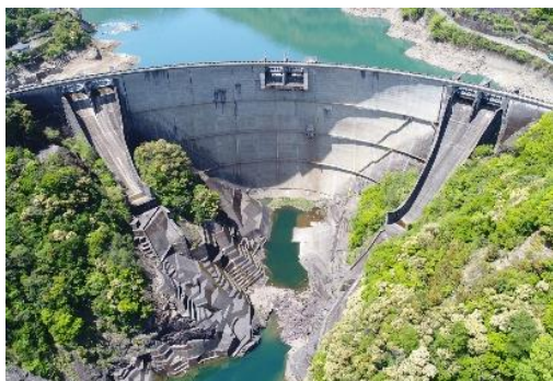
(一ツ瀬ダム全景)
