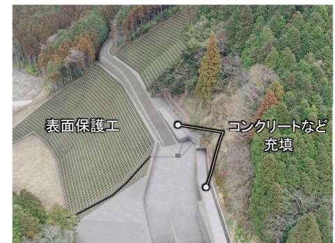
【写真3】 安全対策(ヘッドタンク⑧)
