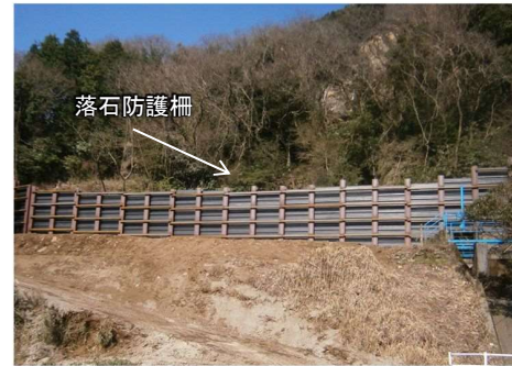
【写真2】 落石防護対策(導水路③)
