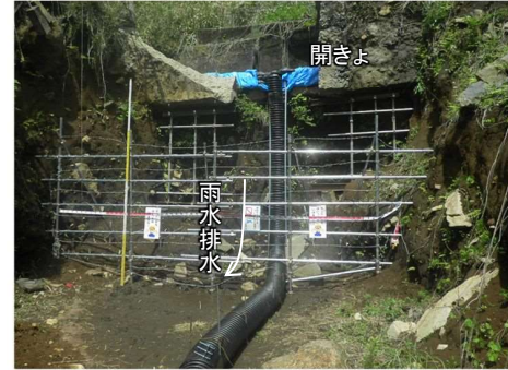
【写真1】 雨水排水対策(導水路②)
