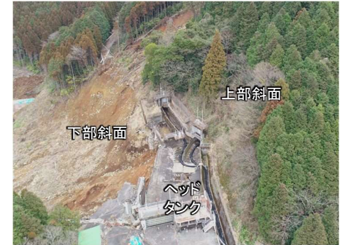
【写真1】 雨水排水対策(導水路②)
