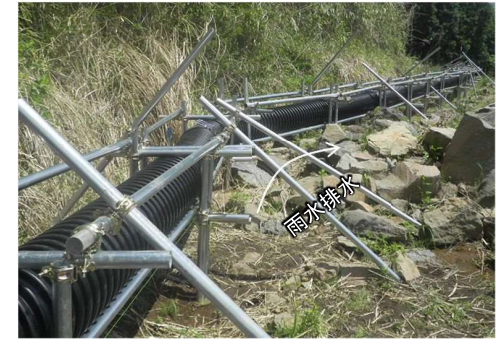
【写真1】 雨水排水対策(導水路②)
