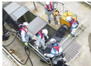
◇海水を取水する水中ポンプの設置
