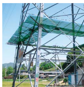
送電鉄塔の昇塔防止装置の設置
