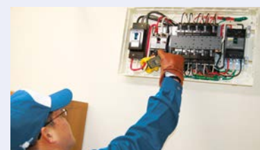
分電盤の点検
