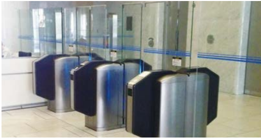
セキュリティゲート(北九州支社)
