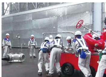
◇放水砲の設置
