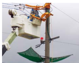
配電工事の落下防止ネット使用
