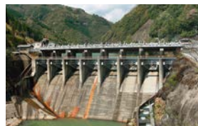
山須原ダム(改造前)
