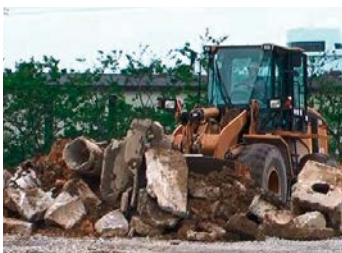
◇重機によるがれき撤去
