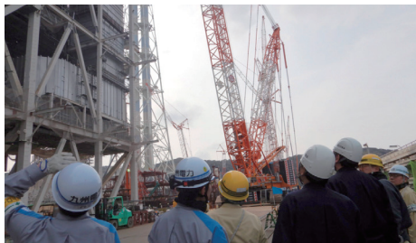
松浦発電所2号機増設に向け大型工事が進捗
