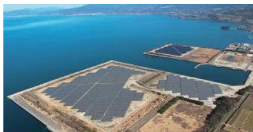
大村メガソーラー発電所
