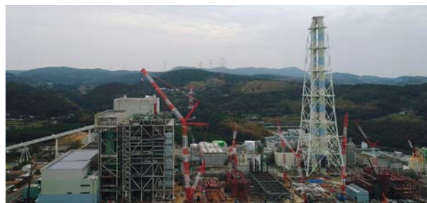
松浦発電所2号機建設状況(2018年3月現在)
