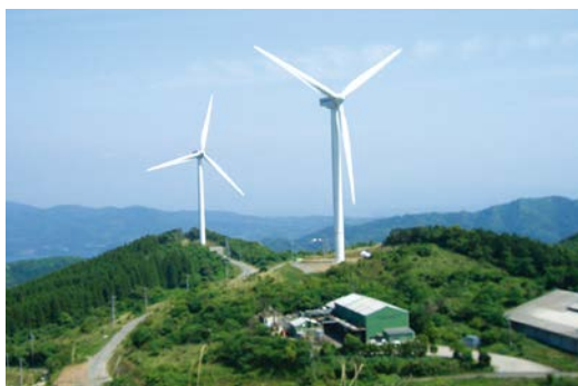
長島風力発電所
