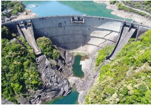
(一ツ瀬ダム全景)
