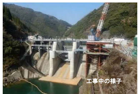
(山須原ダム全景)
