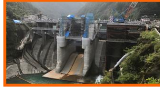
耳川水系で2番目に古いダム(S7運開) 現在、改造工事中(H34.5末運開予定) ラジアルゲートでは日本最大の面積
