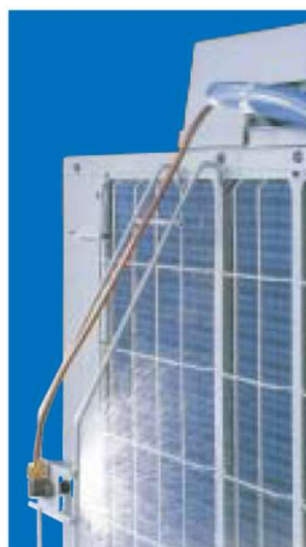
水噴霧の状況
