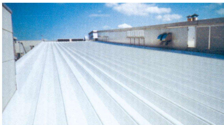
【断熱塗料塗布後】
