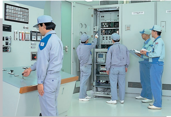
制御棒制御装置
