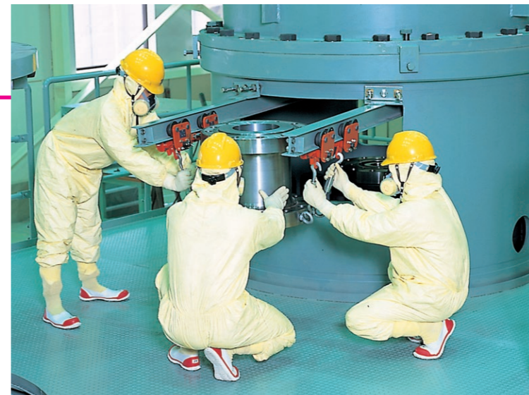
1次冷却材ポンプ軸シールモックアップ
