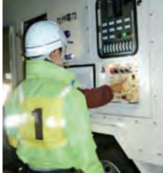
高圧発電機車による電源供給(夜間)
