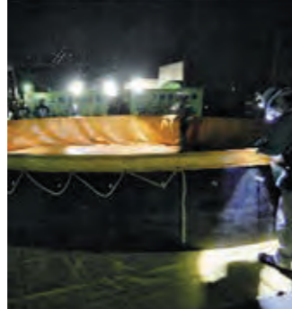
中間受槽の設置(夜間)
