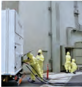
高圧発電機車の電源ケーブル接続
