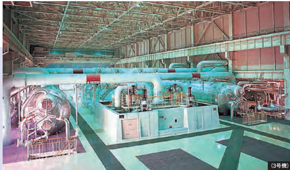
タービン発電機 蒸気発生器で作られた蒸気でタービンを回し、タービンに直結された発電機で電気を発生します。 (3号機)
