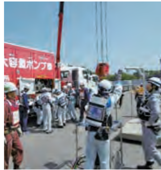
移動式大容量ポンプ車の設置
