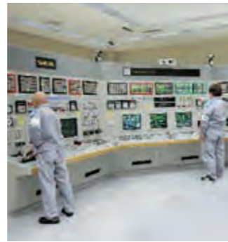
シミュレータを使用した運転操作
