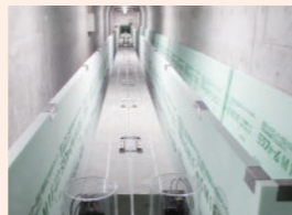
地盤変動検出のための観測坑道
