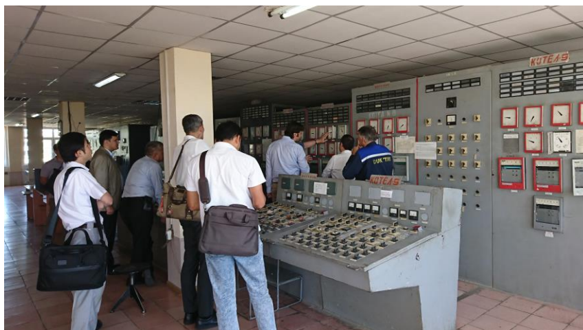
▲ 地域エネルギー供給調査(ウズベキスタン)
