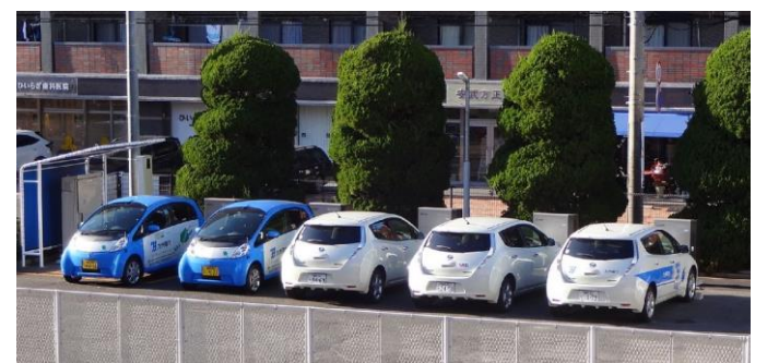
▲ 電気自動車 充放電ステーション
