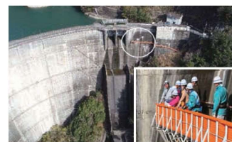
宮崎県でのインフラツーリズム (上椎葉ダム点検通路歩行体験)
