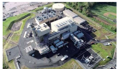
米・バースボローガス火力発電所 (2019年5月営業運転開始) (コンバインドサイクル方式。最新鋭の高効率ガスタービン採用)
