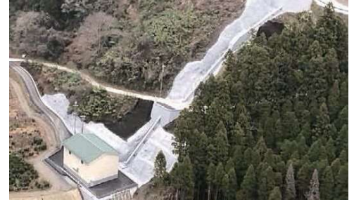
鴨猪水力発電所 (年間約960万kWh (一般家庭約3,200世帯相当)の発電電力量)
