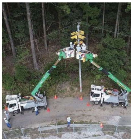
配電線路復旧
