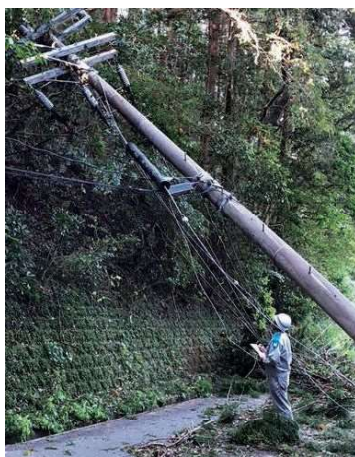
電柱折損復旧対応
