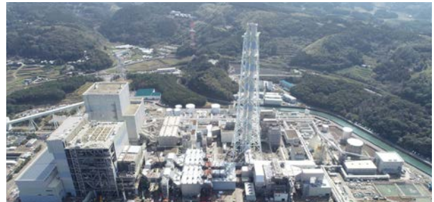
松浦発電所2号機建設状況(2019年3月現在)
