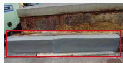
モルタル補修材による仕上がり状況【補修後】
