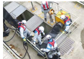
◇海水を取水する水中ポンプの設置
