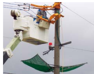
配電工事中の落下防止ネット使用
