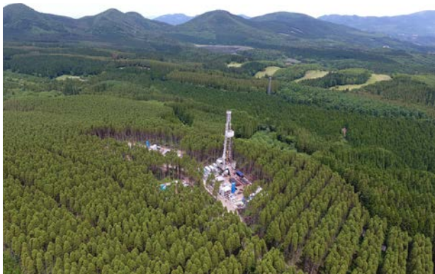
山下池南部地域調査井掘削状況
