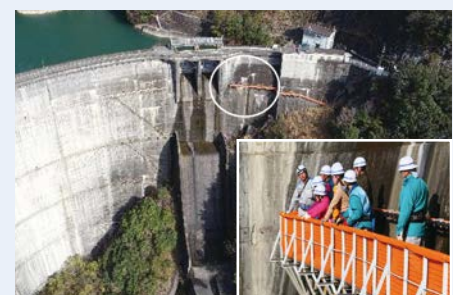
宮崎県上椎葉ダム点検通路歩行体験
