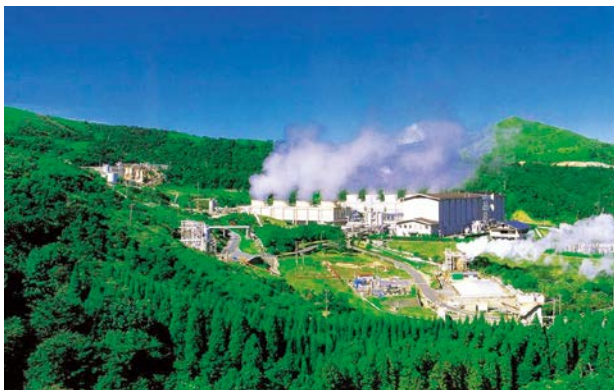
八丁原発電所
