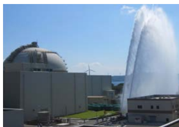
◇放水砲による放水
