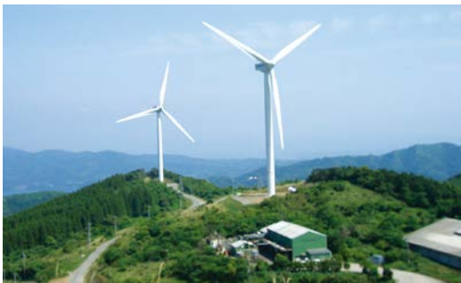
長島風力発電所
