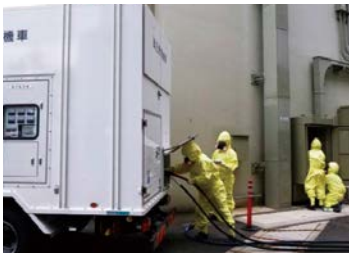
◇高圧発電機車の電源ケーブル接続
