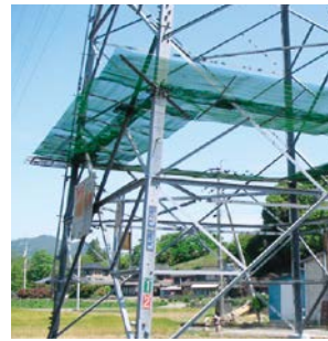
送電鉄塔の昇塔防止装置の設置
