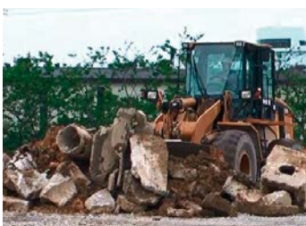
◇重機によるがれき撤去
