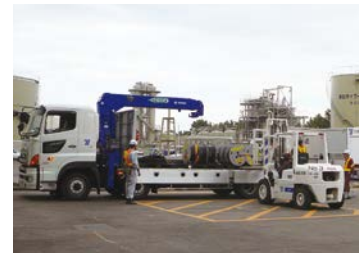
◇電源ケーブルの運搬
