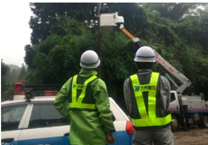
九州北部豪雨復旧作業
