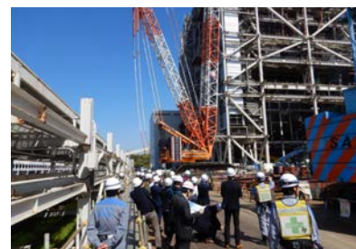
松浦2号機増設工事現場公開
