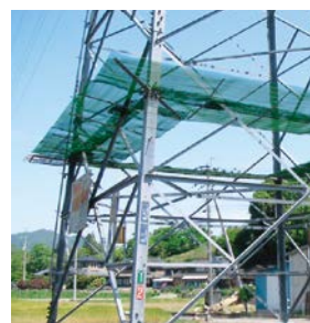
送電鉄塔の昇塔防止装置の設置
