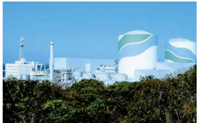
川内原子力発電所
