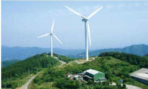
長島風力発電所
