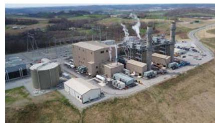
ウエストモアランド ガス火力発電所(アメリカ)
