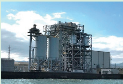
国内最大級の木質バイオマス発電所 (豊前バイオマス発電所)
