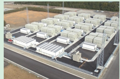
蓄電池システムを活用した再生可能エネルギーの受入れ (豊前蓄電池変電所)
