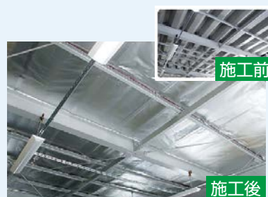
夏場ピーク時の屋根からの熱量を約9割カットする 「遮熱シート(トップヒートバリアー)」
