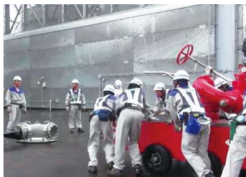
◇放水砲の設置
