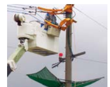
配電工事中の落下防止ネット使用
