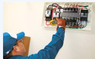
分電盤の点検
