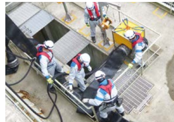
◇海水を取水する水中ポンプの設置
