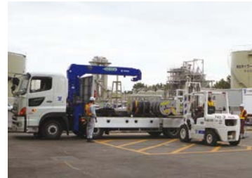
◇電源ケーブルの運搬
