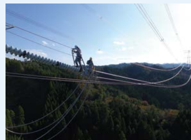
日向幹線建設工事
