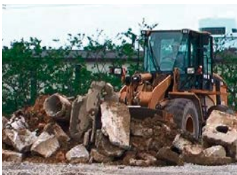
◇重機によるがれき撤去
