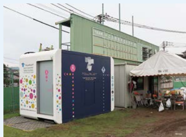
被災地に設置した完全自己処理型水洗トイレ 「トイレ」
