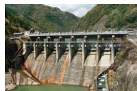
山須原ダム(改造前)
