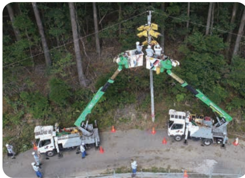
配電線路復旧
