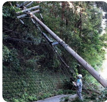
電柱折損復旧
