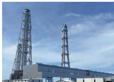
新大分発電所(大分県)
