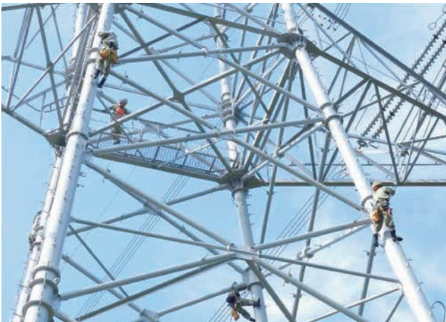
送電鉄塔の設備点検
