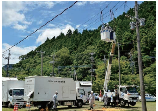
台風前の停電復旧訓練
