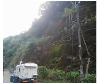
高圧発電機車による応急送電
