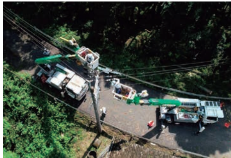
復旧作業の様子
