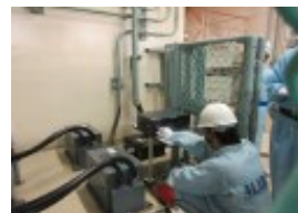
原子炉停止用地震計 の点検
