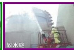
放射線物質の 放出を抑制する 放水砲の配備
