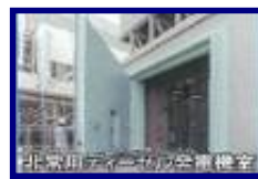
浸水を防ぐ 水密扉の設置
