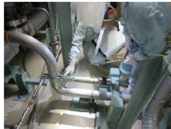
配管の支持装置点検
