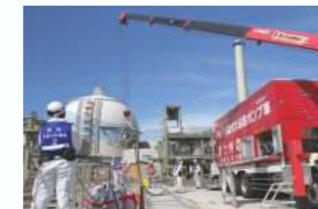
移動式大容量ポンプ車による冷却水供給訓練を実施
