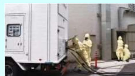
高圧発電機車の電源ケーブル接続
