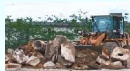
重機によるがれき撤去
