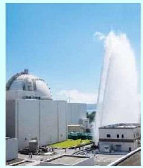
放水砲による放水
