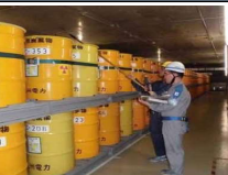
保管容器の固縛状態点検
