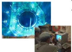
原子炉圧力容器内の点検(水中カメラ)
