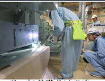
ポンプの基礎ボルト点検
