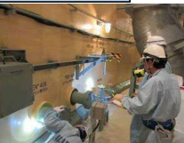
格納容器貫通部点検
