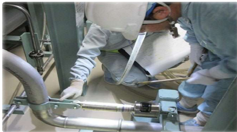
配管の支持装置点検の様子
