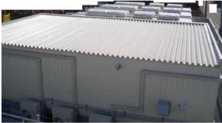
蓄電池収納建屋写真
