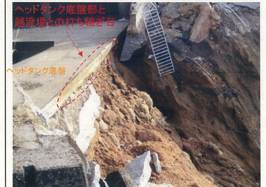
写真2.3 ヘッドタンク底盤と越流堤の打ち継ぎ目 (撮影:H28.5.15)
