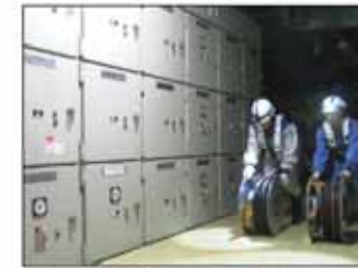
◇電源ケーブル敷設
