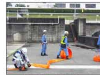
◇仮設ホースの敷設
