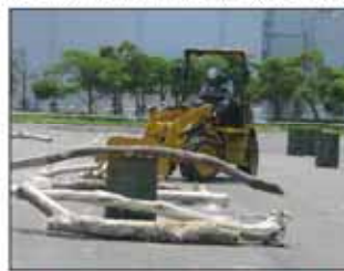
◇小型ホイールローダによるがれき撤去
