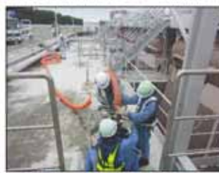
◇仮設ポンプより海水を取水
