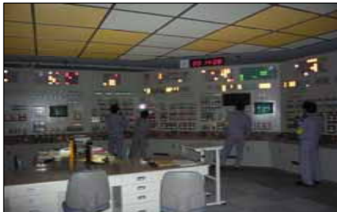
訓練シミュレータを使った全交流電源喪失訓練 (川内原子力訓練センター内)
