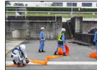
仮設ホースの布設
