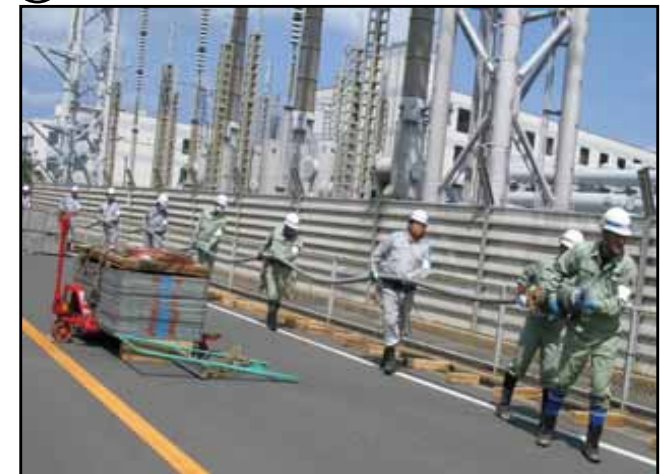
Ⓒ 電力ケーブルの布設
