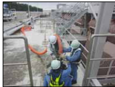
仮設ポンプより海水を取水
