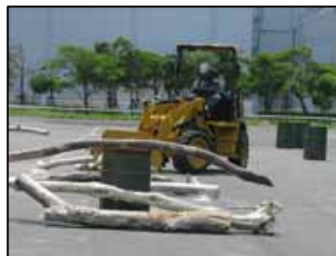
小型ホイールローダによるガレキ撤去
