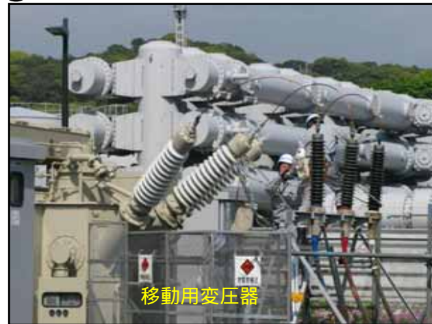
Ⓑ 移動用変圧器へのつなぎ込み
