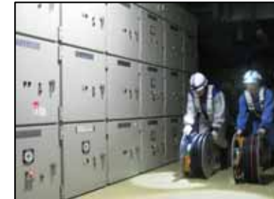
電源ケーブル布設
