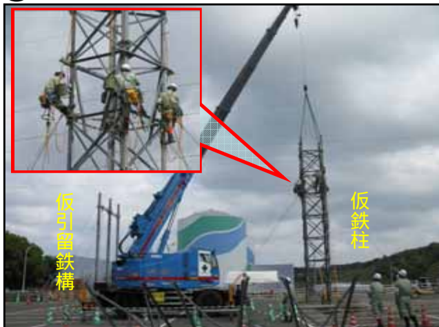
Ⓐ 仮鉄柱・仮引留鉄構の建柱
