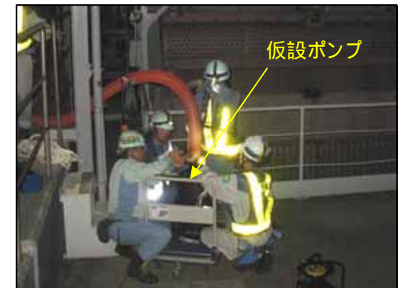
仮設ポンプの設置
