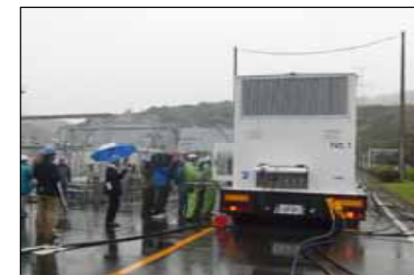
移動式大容量発電機による電源供給訓練
