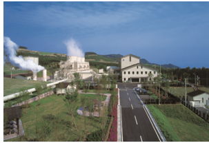
（大霧地熱発電所）
